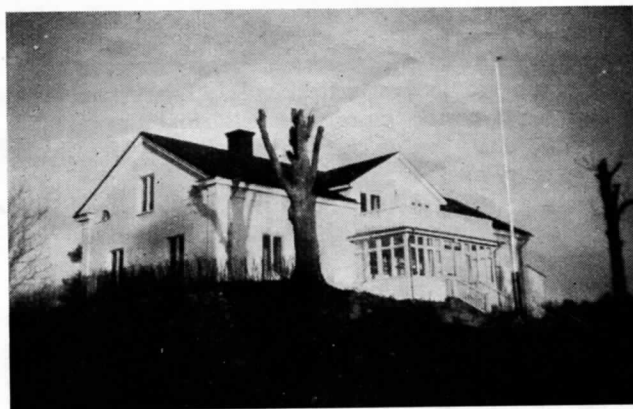
Jonsbergs prästgård, restaurerad och moderniserad 1954. Uppfördes på 1760-talet. Innehåller åtta rum och kök samt hallar. Då Jonsberg 1867 blev eget pastorat och prästgården därmed kyrkoherdebostad, skedde en tillbyggnad på västra gaveln, då kyrkolagen stadgade att en kyrkoherdes bostad skulle innehålla ytterligare två rum.
